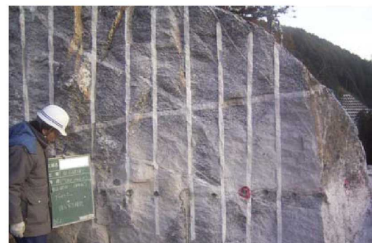
写真 3.2-9 騒音の低減(静的破碎工法)
