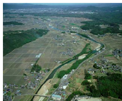
木津川（三重県管理区間）67～69k 付近
