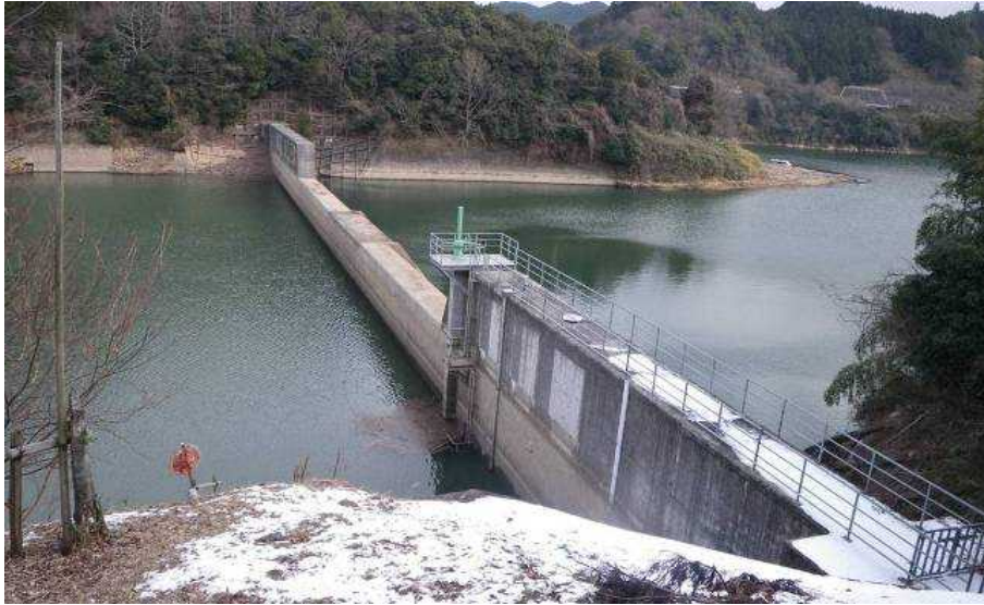
図 4.5-20 貯砂ダム（布目ダム）
