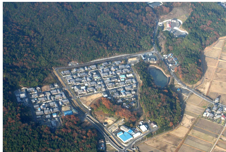
水没家屋の集団移転状況
