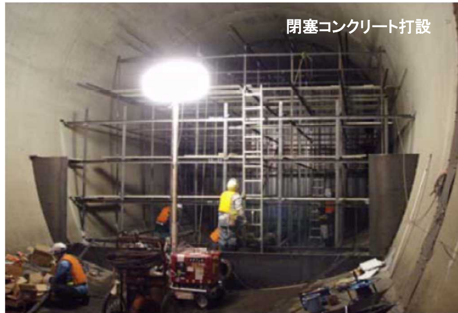
転流工閉塞状況写真（他ダム事例）
