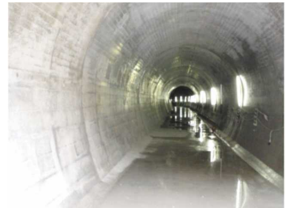
仮排水路内部施工状況 (他ダム事例)
