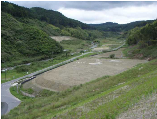
建設発生土処理（他ダム事例）
