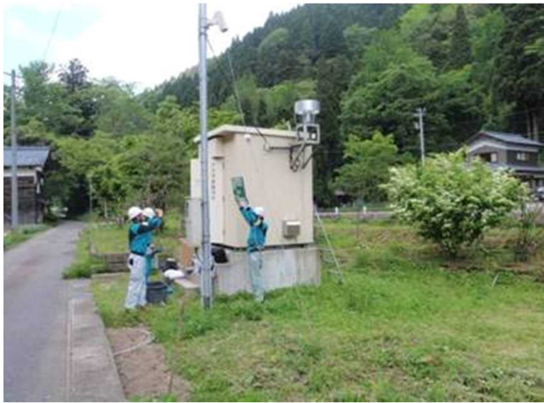
雨量観測所写真（他ダム事例）
