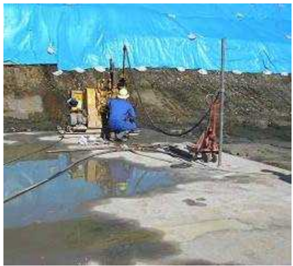
グラウチング状況 (他ダム事例)
