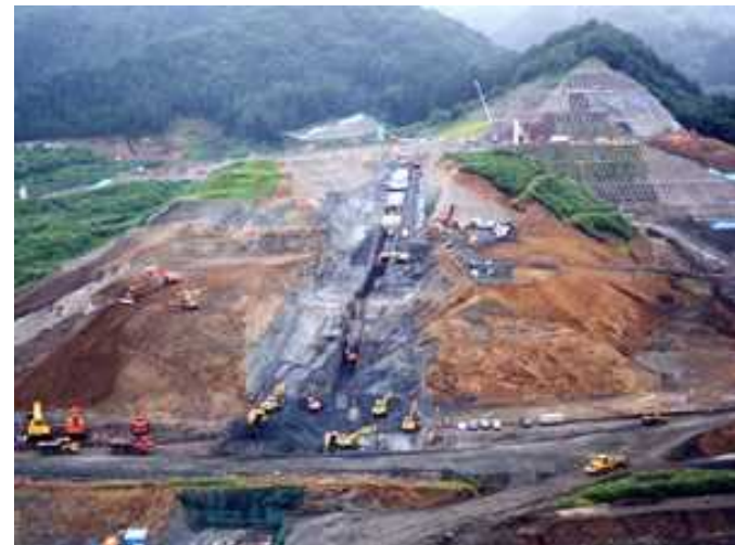
基礎掘削（他ダム事例）
