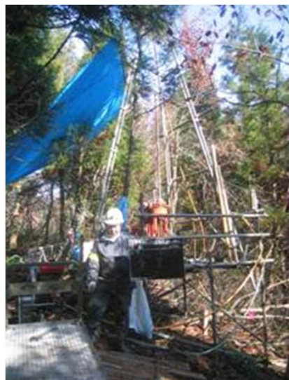
地質調査状況写真
