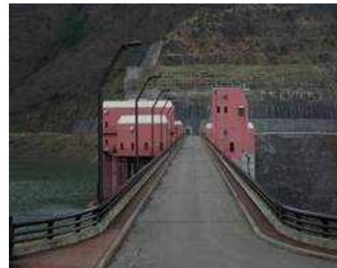
照明設備写真 (他ダム事例)
