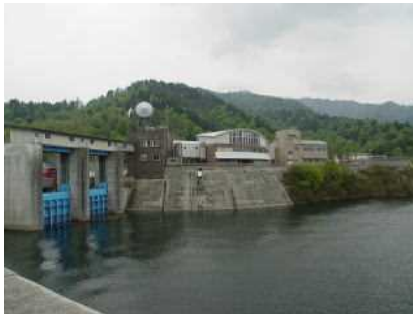
管理事務所写真（他ダム事例）
