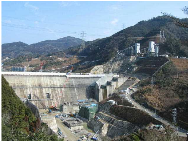
堤体工 (他ダム事例)
