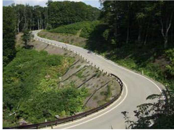
工事用道路写真（他ダム事例）
