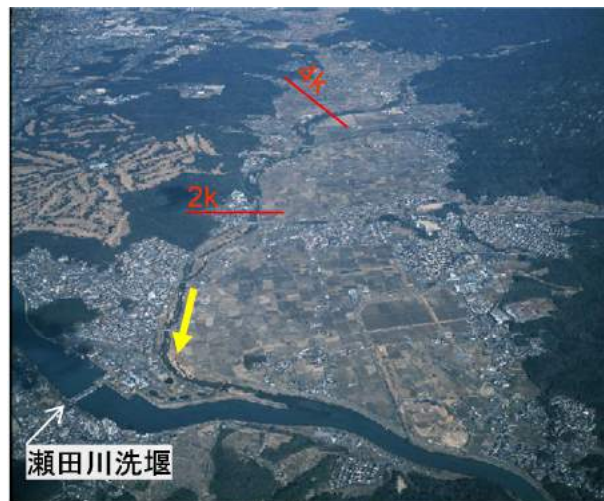
大戸川 (滋賀県管理区間) 0~4k 付近
