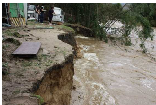
写真 2.2-6 大津市石居の河岸洗堀
