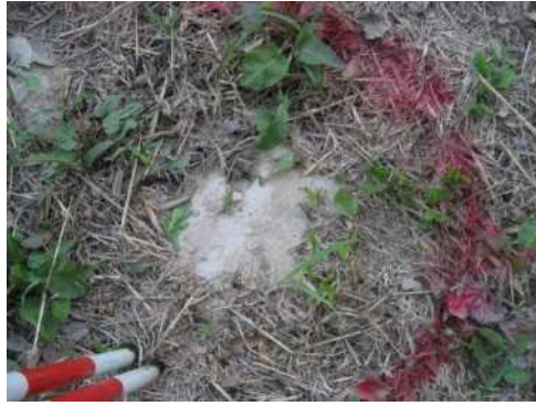
写真 2.2-8 京都府久御山町の堤防漏水による噴砂
