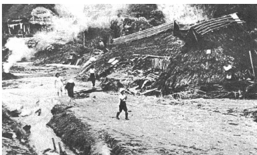
写真 2.2-1 甲賀市信楽町多羅尾村の家屋被害
