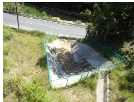
写真 3.2-1 沈砂池の設置状況
