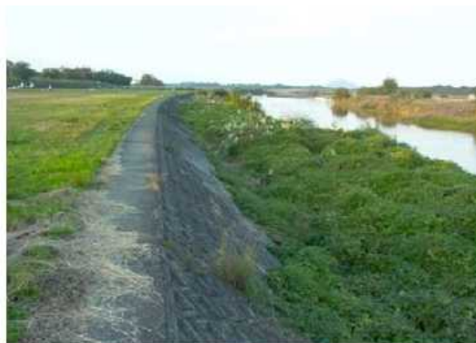
写真 2.3-3 コンクリート護岸
