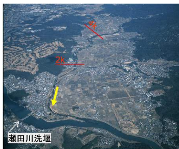
大戸川（滋賀県管理区間）0～4k 付近
