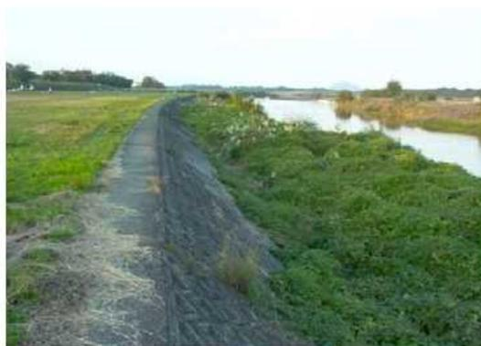
写真 2.3-3 コンクリート護岸
