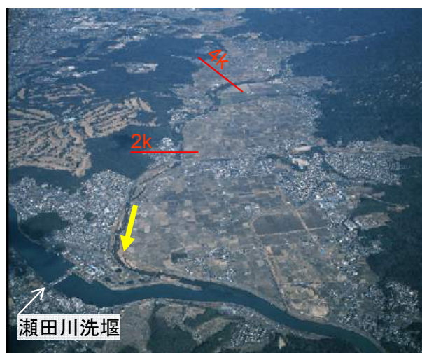
大戸川（滋賀県管理区間）0～4k 付近
