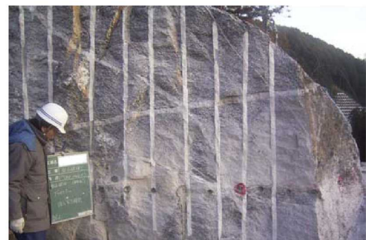
写真 3.2-9 騒音の低減(静的破碎工法)
