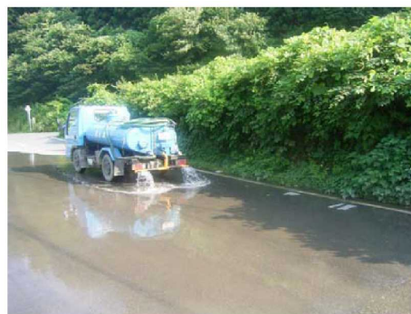
写真 3.2-1 散水の実施状況
