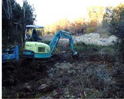
写真 3.2-11 周辺表土の採取・まき出し
