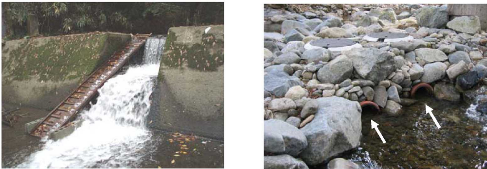
移動経路の確保状況
