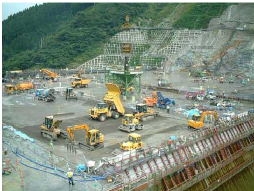
堤体工（他ダム事例）
