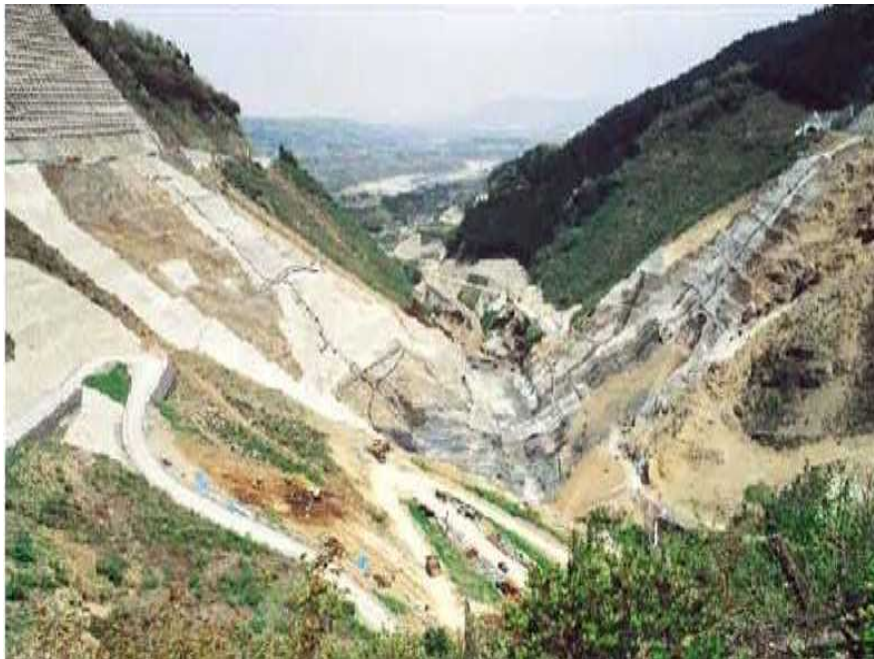
基礎掘削（他ダム事例）
