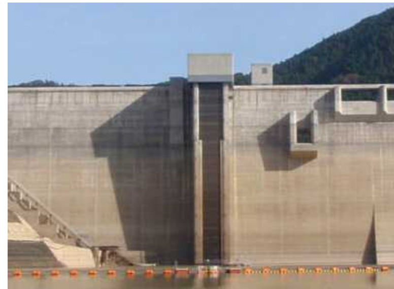
選択取水設備（他ダム事例）
