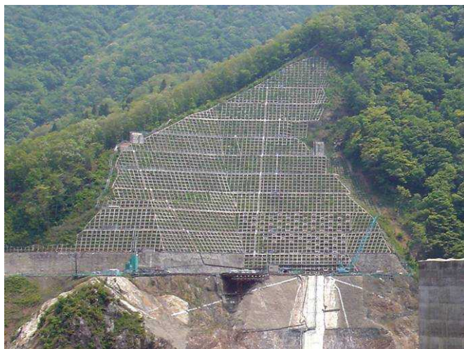
ダムサイト法面保護工 (他ダム事例)
