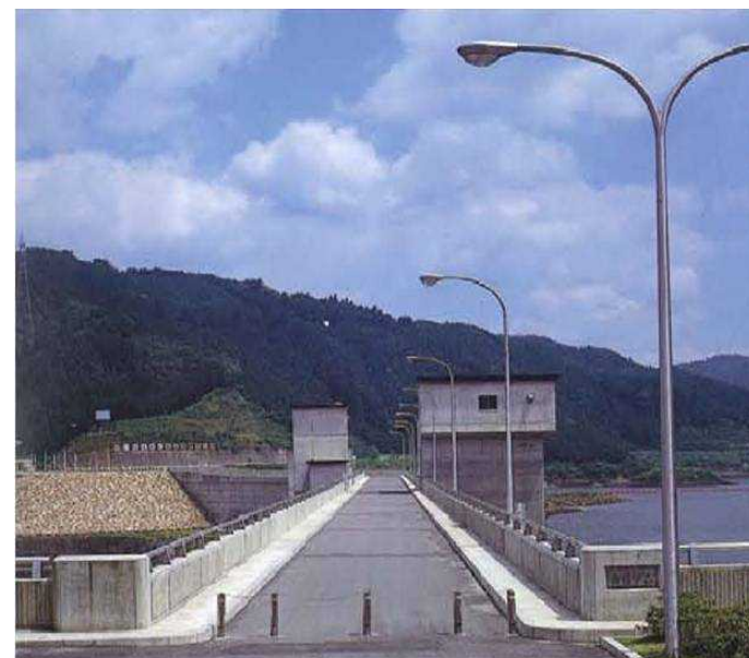
照明設備（他ダム事例）
