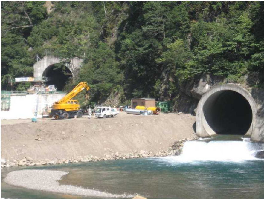
仮排水トンネル（他ダム事例）
