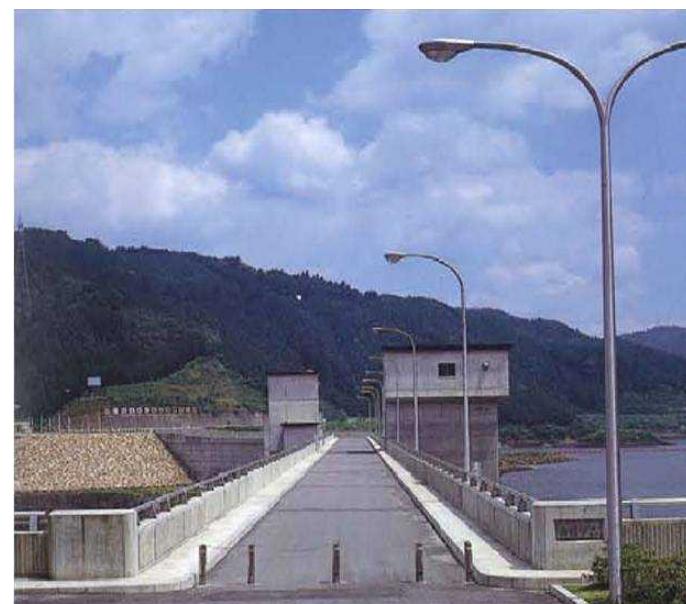
照明設備（他ダム事例）
