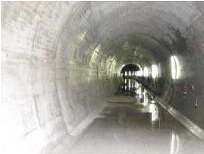
仮排水トンネル（他ダム事例）
