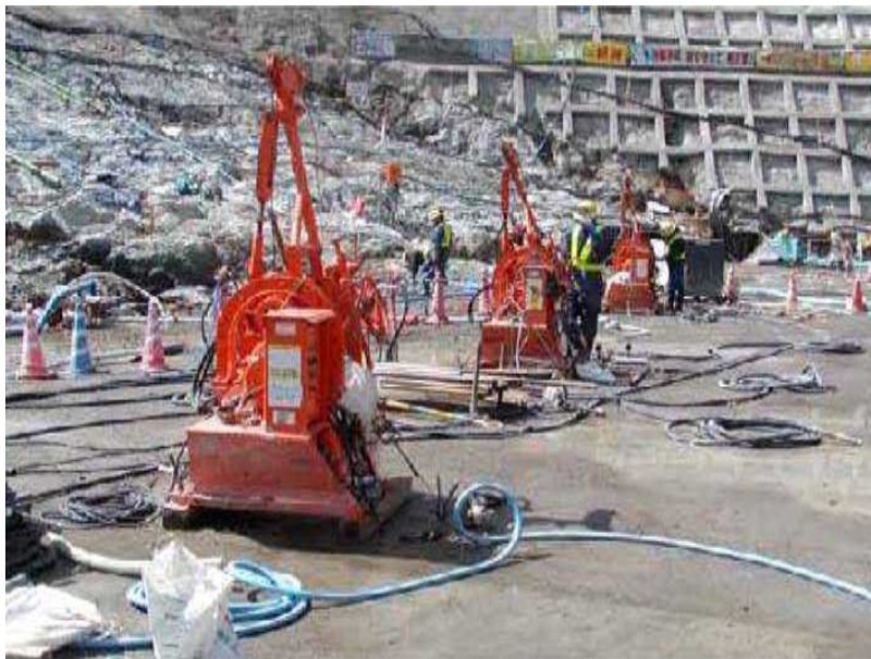
グラウチング状況 (他ダム事例)
