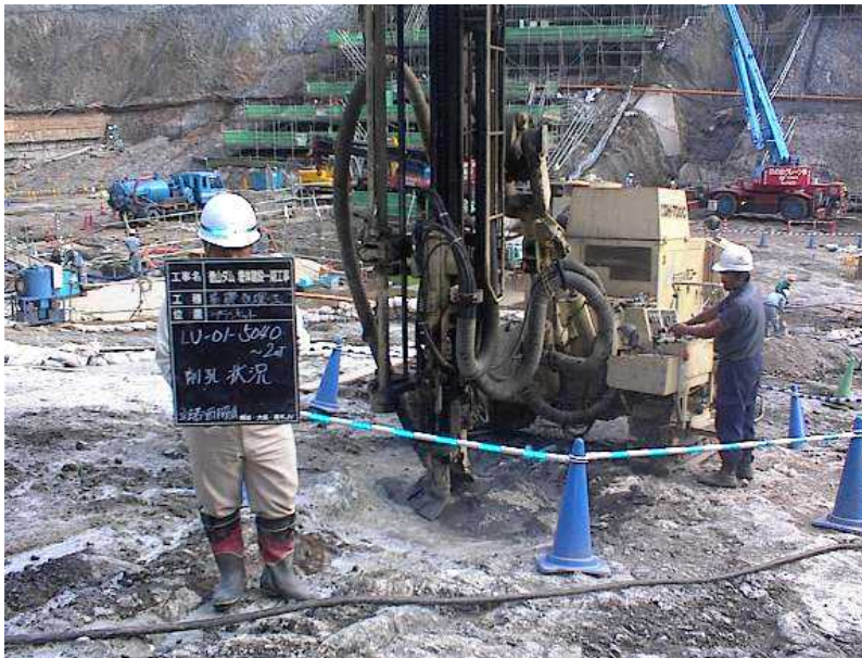
グラウチング状況 (他ダム事例)
