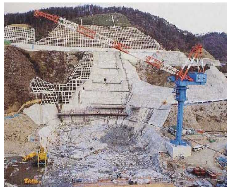
堤体工（他ダム事例）
