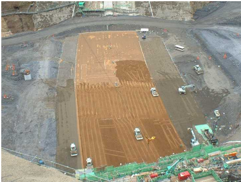
堤体工（他ダム事例）
