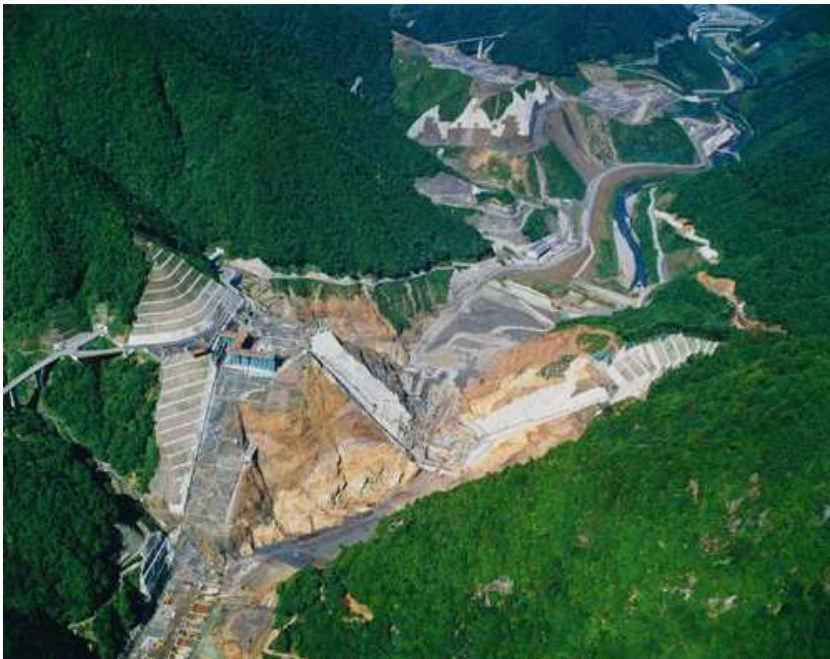
基礎掘削（他ダム事例）
