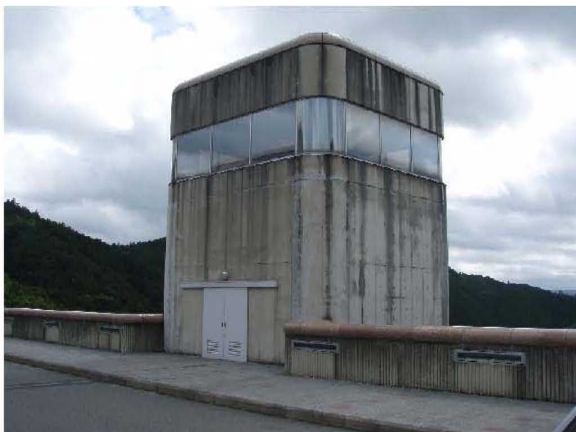
エレベータ設備（他ダム事例）
