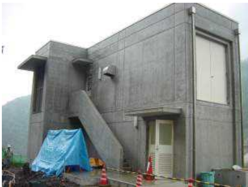
エレベータ設備（他ダム事例）
