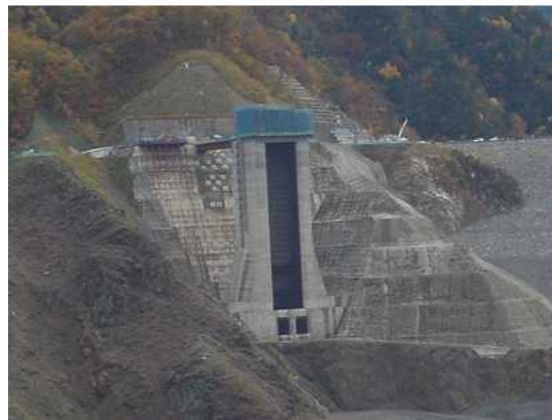
選択取水塔（他ダムの事例）
