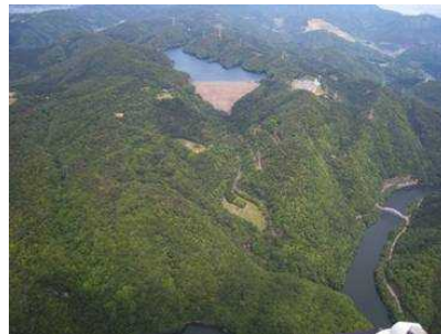
喜撰山ダム（揚水式発電の上池）
