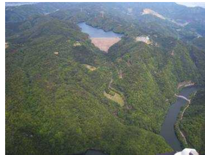
喜撰山ダム（揚水式発電の上池）
