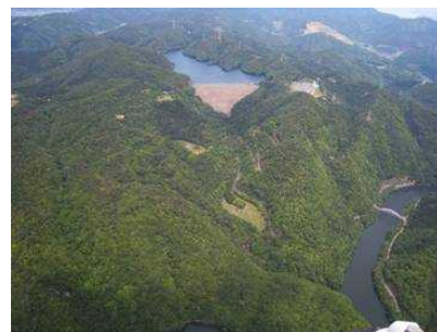
喜撰山ダム（揚水式発電の上池）
