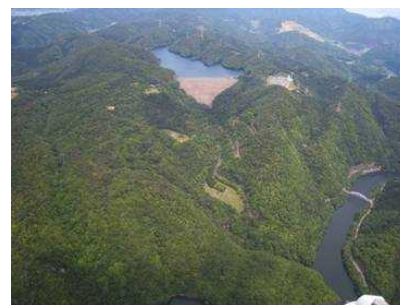
喜撰山ダム（揚水式発電の上池）
