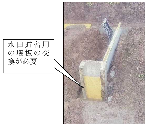
写真 4.8 水田排水ますの例
