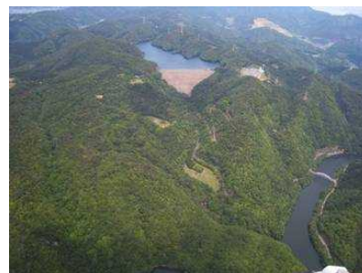
喜撰山ダム（揚水式発電の上池）
