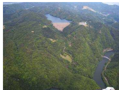
喜撰山ダム（揚水式発電の上池）
