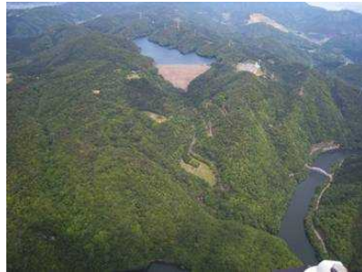
喜撰山ダム（揚水式発電の上池）
