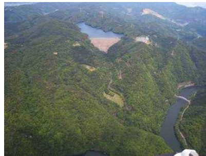
喜撰山ダム（揚水式発電の上池）
