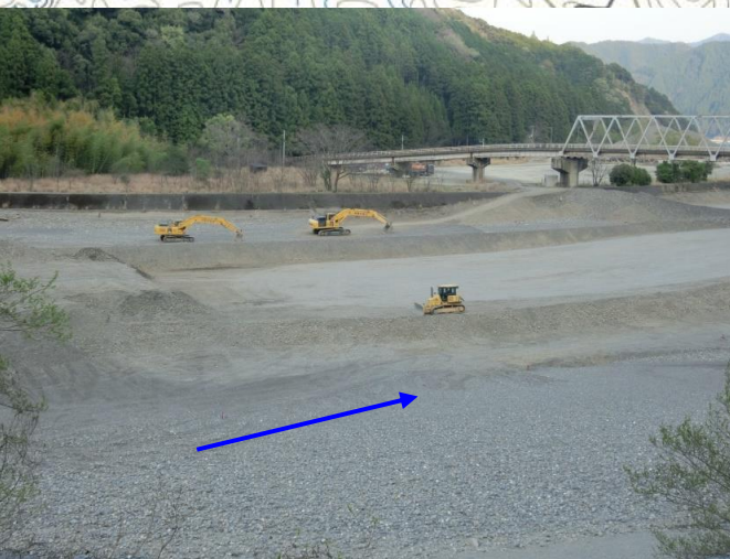
本宮地区 土砂撤去
