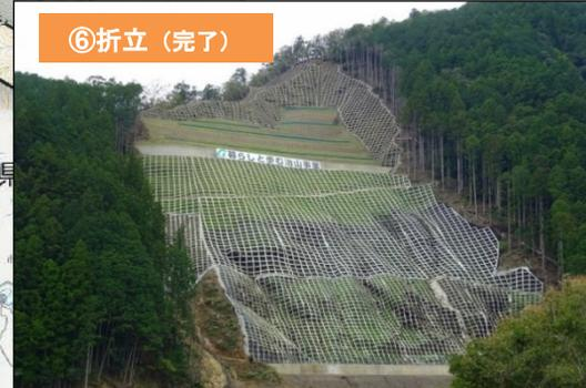
山腹工(法枠工・土留工・緑化工)
