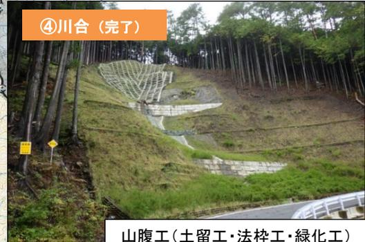
山腹工(土留工・法枠工・緑化工)
