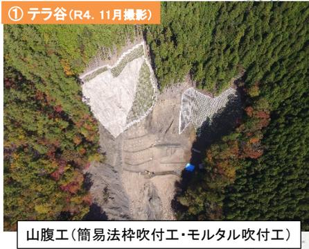
山腹工(簡易法柱吹付工・モルタル吹付工)
