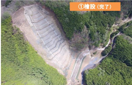
溪間工(コンクリート谷止工・かご枠護岸工・鋼製枠帯工)
