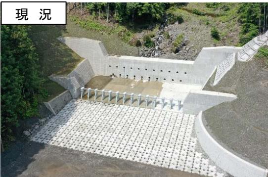
砂防堰堤等の整備により土砂流出を抑制
