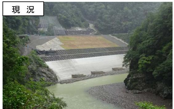
地すべり対策施設の整備により土砂流出を抑制
