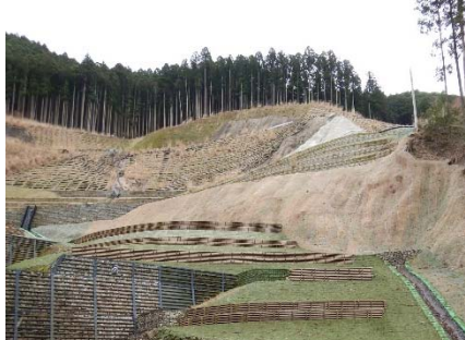
▲R1施工状況
