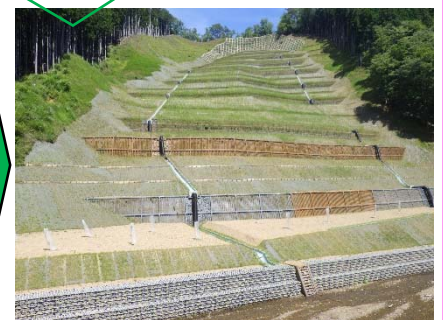
▲R4撮影(施工後半年経過)
