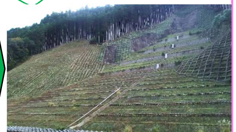
▲R4撮影(施工後3年半経過)
