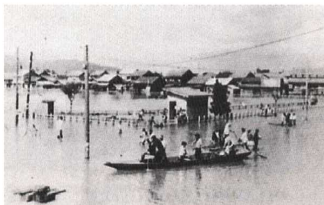
福井市花月町付近の浸水状況
