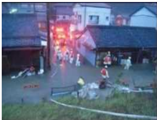
国土交通省と消防による排水作業
