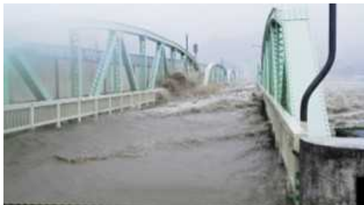
旧熊野川大橋からの越水(右岸)
