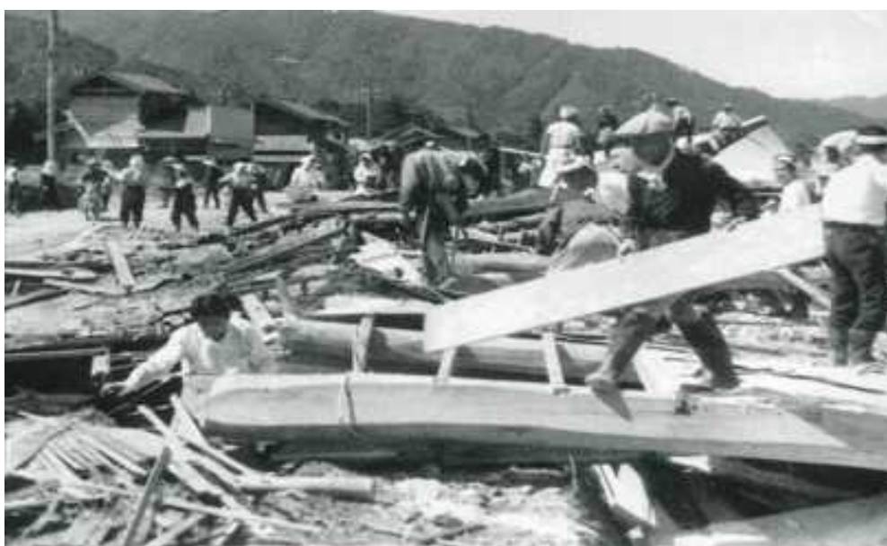
旧上志比村(現永平寺町)の被災状況
