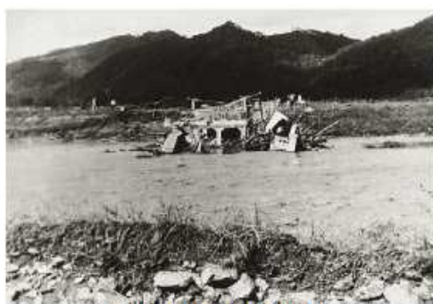
まるやま 流出した丸山橋
