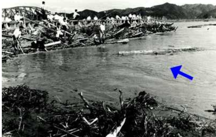
和歌山市南海橋の被害状況
