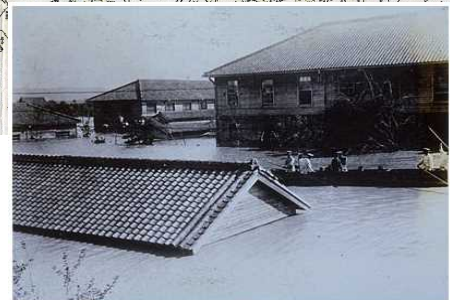
高槻市三島江兵隊舎の浸水状況
