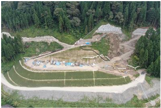
付替道路土工施工状況 (R4. 9)
