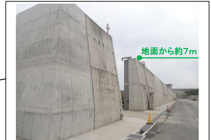
護岸の整備状況
