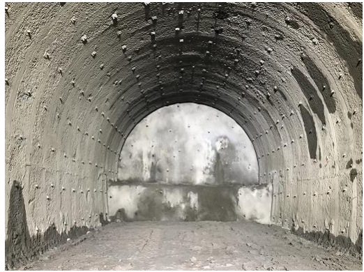
水海川導水トンネル施工状況 (R4. 9)
