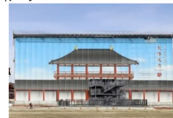
東楼整備のための素屋根
