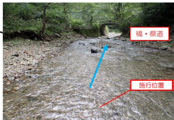
施工位置(大音波川橋付近)
