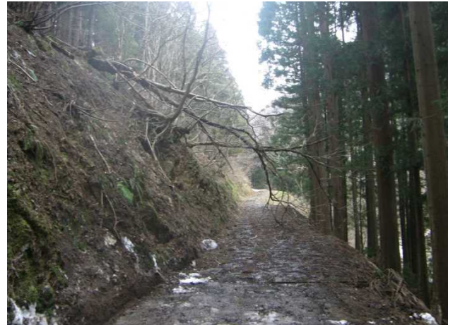
倒木(水源地域の荒廃状況)
