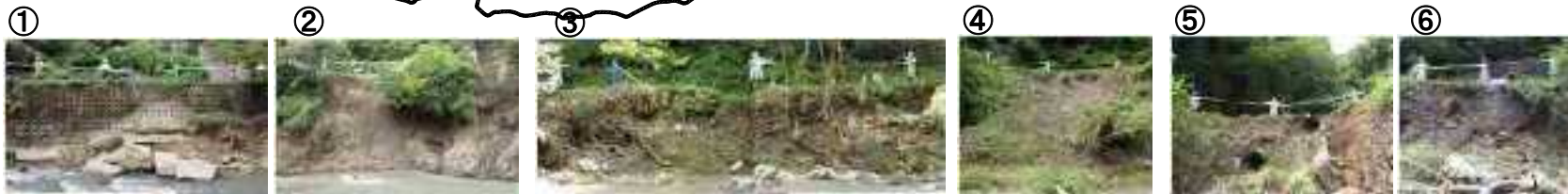
中河内木之本線 被災状況
