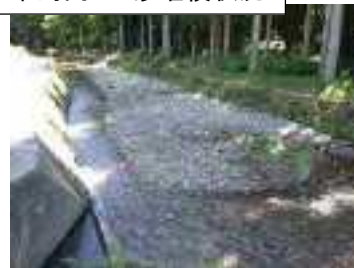
中河内：土砂堆積状況
