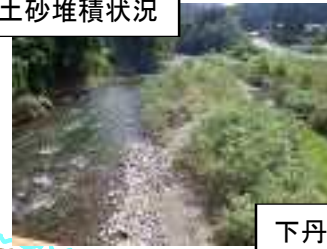
土砂堆積状況
