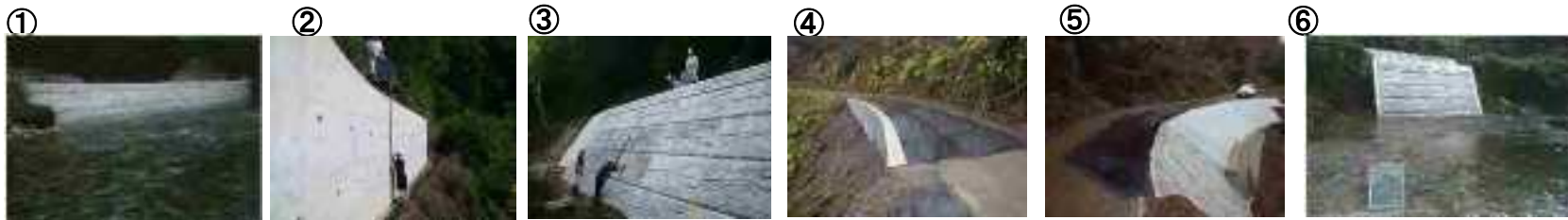
中河内木之本線 復旧状況
