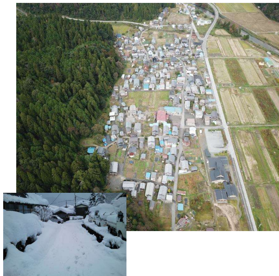
消雪施設整備
