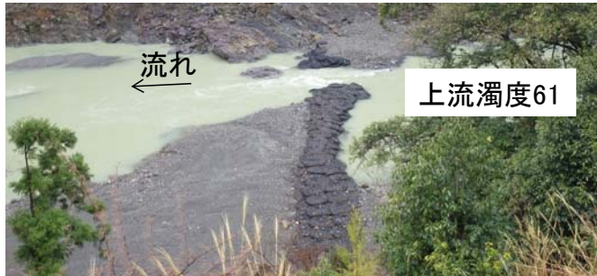
沈殿池工（上流）（H29.4.1 流量約20m 3 /s）
