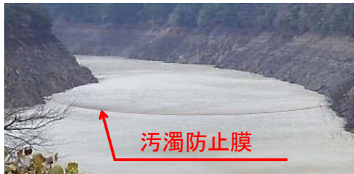
風屋ダム汚濁防止膜 (H28.12.23)
