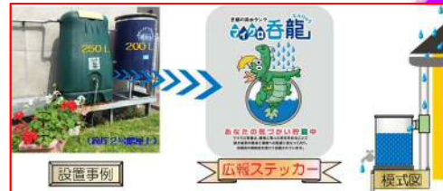
設置事例 マイクロ呑龍(各戸雨水貯留施設)
