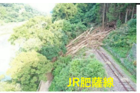
7/9 熊本県球磨村一勝地 山腹崩壊により鉄道・県道に土砂流出
