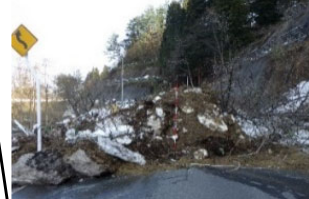
4/12 山形県西川町吉川 雪崩とともに土砂・立木が崩落し、県道が被災
