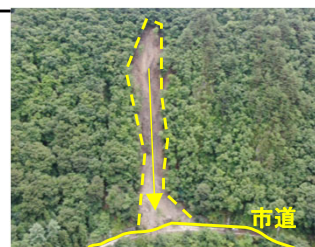
7/23 岩手県宮古市鈴久名 山腹崩壊により市道に土砂流出
