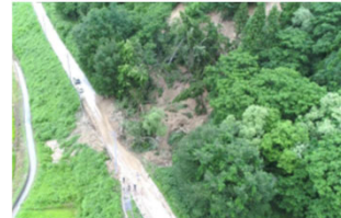
8/3 山形県飯豊町高峰 山腹崩壊により農業用水路が被災
