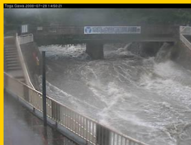
写真3.2008年7月28日都賀川甲橋の様子（前10分間で約1.3m水位が上昇） (出典：片山ら,2015)
