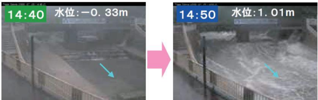
写真4. 都賀川甲橋の水位上昇の状況（10分間で1.3m以上の水位上昇） （出典：片山ら,2015）
