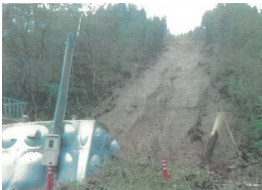
9/19 宮崎県五ヶ瀬町 台風第14号により山腹崩壊が発生、飲用水施設が被災
