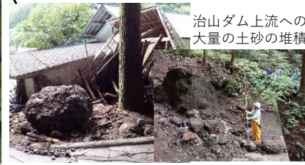
8/6 長野県長野市鬼無里 林地荒廃により人家、国道及び市道に土砂流出
