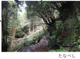
8/14 和歌山県田辺市 山腹崩壊により市道に土砂流出
