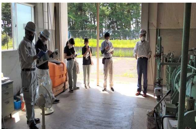
令和4年7月29日 野田排水機場
