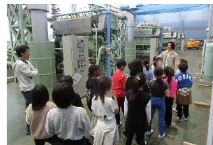
排水機場の見学
