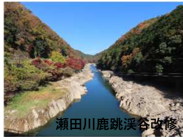
河川改修・維持管理
