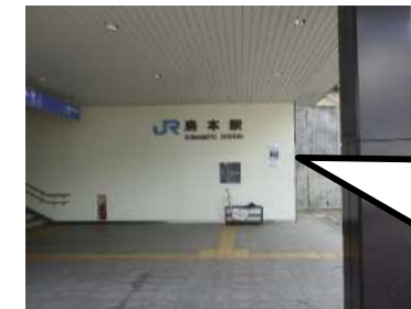
浸水深2.2mJR島本駅東口
