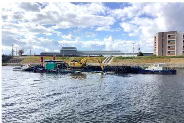
戸ノ内地区河道掘削（国土交通省）
