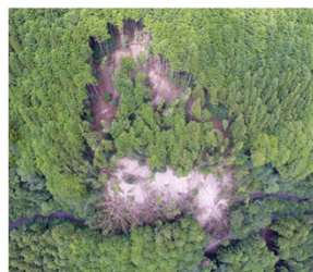
はいばらぐんかわねほんちょう 8月 静岡県榛原郡川根本町 山腹崩壊により林道へ土砂流出
