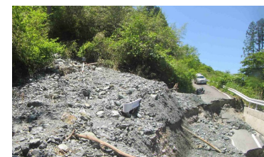
ながおかぐんおおとよちょう 5月 高知県長岡郡大豊市 豪雨により林道へ土砂流出
