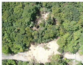
やつしろうし 6月 熊本県八代市 山腹崩壊により林道へ土砂流出
