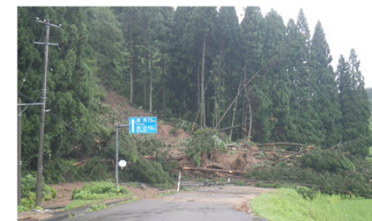
きたあきたぐん かみこあにむら 7月 秋田県北秋田郡上小阿仁村 山腹崩壊土砂が県道へ土砂流出
