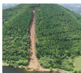
さつませんだいし 6月 鹿児島県薩摩川内市 山腹崩壊により町道やため池へ土砂流出
