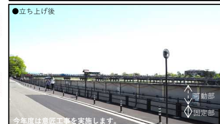
可動式止水壁の立ち上げ状況 (令和3年4月)
