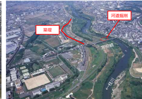
大下津地区・淀水垂地区 (京都市伏見区淀水垂地先)
