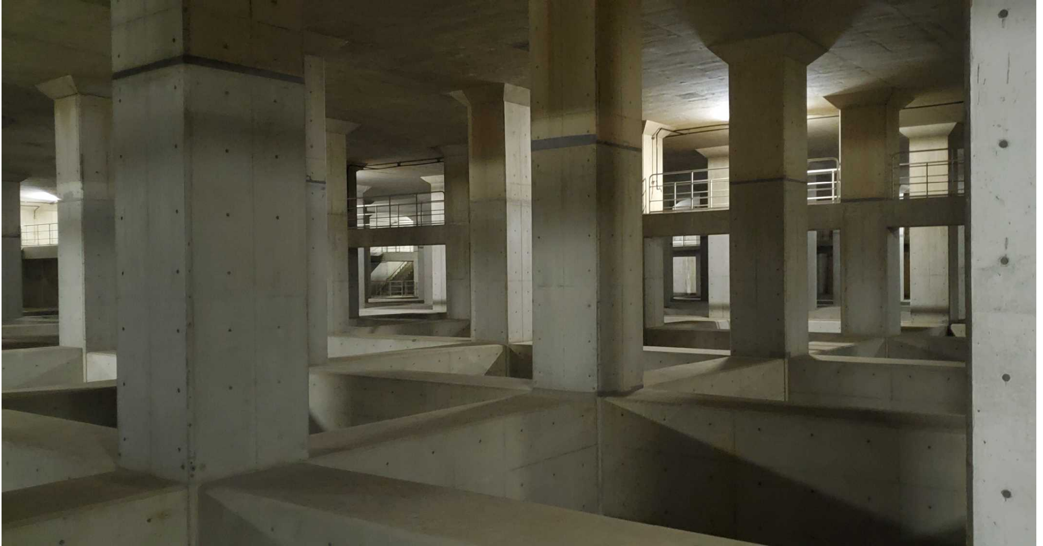
八戸の里公園調節池内部
