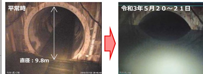
平常時 直径：9.8m 令和3年5月20～21日 南部地下河川での貯留状況
