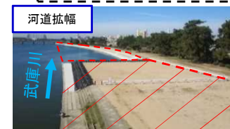
河道拡幅 武庫川下流部
