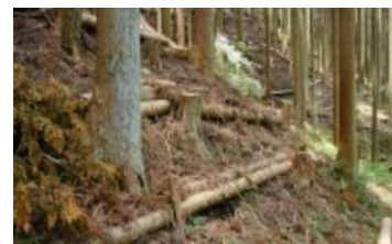
伐倒木を利用した土留工の設置例
