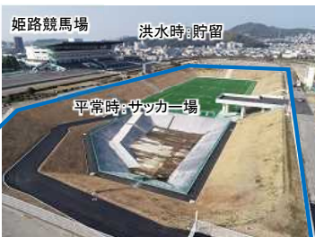
船場川調節池(姫路市) 平成30年3月完成 ・洪水調節容量 12万 m^3
