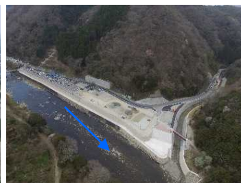
武庫川(宝塚市)武田尾住宅地区治水対策 平成30年3月完成
