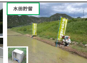
水田貯留 水田貯留(三田市)等
