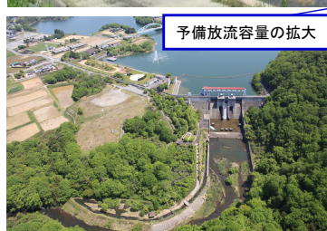
青野ダム(多目的) 事前放流40万 m^3 (H21.2 20万 m^3 運用開始・R2.6容量拡大・今後予備放流化)
