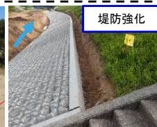
堤防強化 武庫川下流部(この後復土30cm施工)
