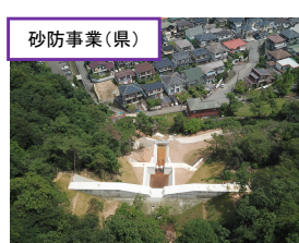
砂防事業(県) 高尾谷西堰堤(西宮市)等
