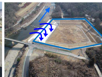
武庫川遊水池(神戸市) 平成31年3月完成 ・洪水調節容量 7万 m^3
