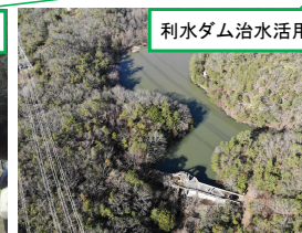
名塩ダム(西宮市水道) 通年水位低下5.8万 m^3 (流域貯留浸透事業R3.6運用開始予定)
