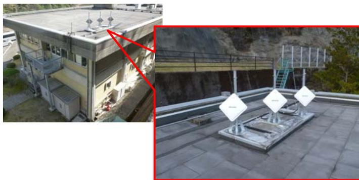
衛星電話のアンテナ設置状況
