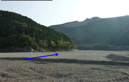
本宮地区 土砂撤去
