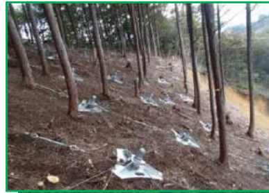
H25地山補強土工 完成状況
