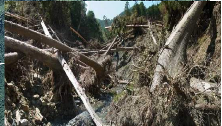
土石・流木等堆積状況
