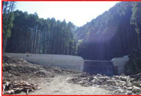
第3号コンクリート谷止工 完成状況
