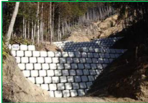
H25第2号谷止工 完成状況
