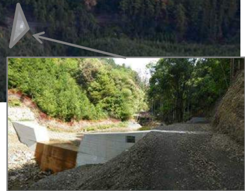
H24和歌山県施工
