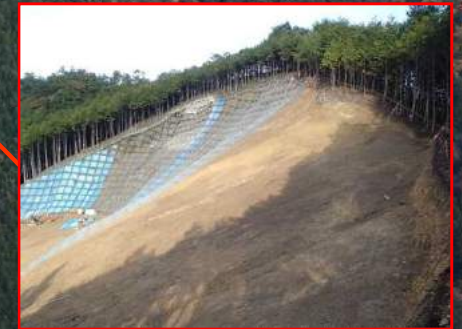
法枠工 施工状況
