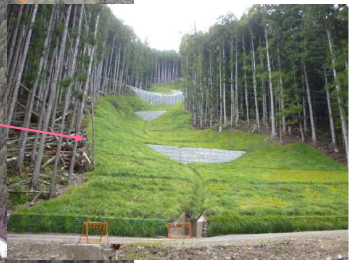
山腹工 完成状況 (村道下部)
