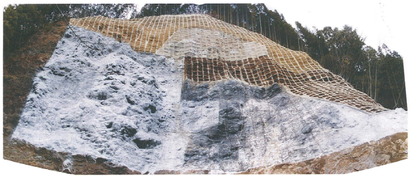
山腹工 完成状況
