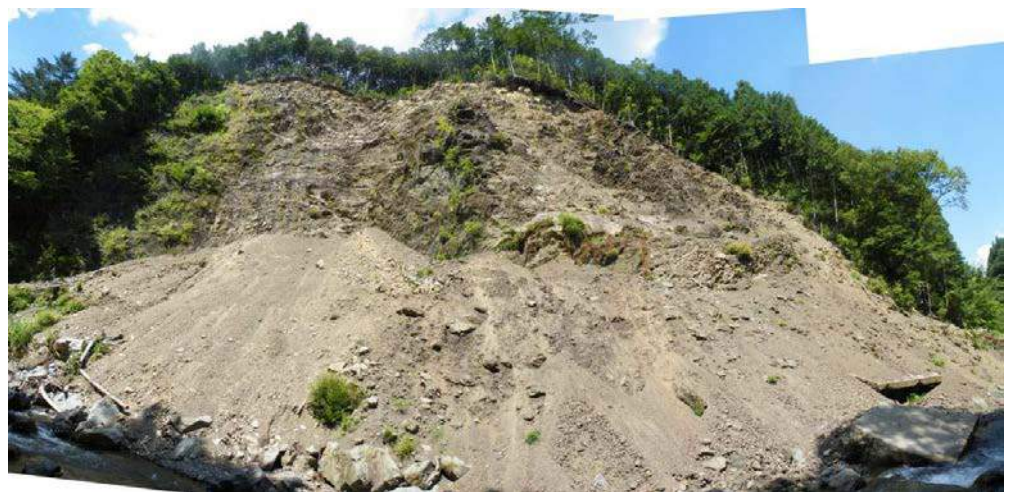
山腹工 施工前状況
