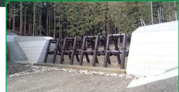
H25第2号谷止工 完成状況
