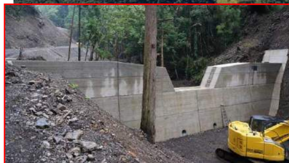
第1号谷止工 完成状況
