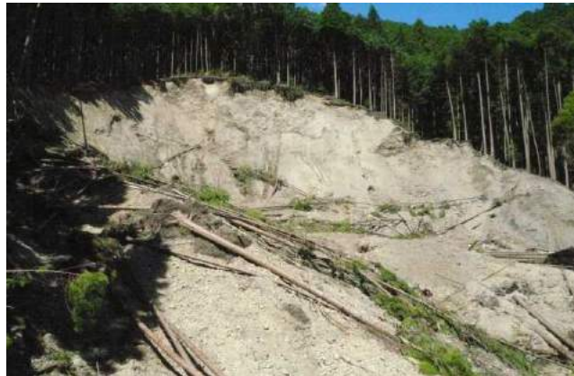
山腹崩壊地の状況
