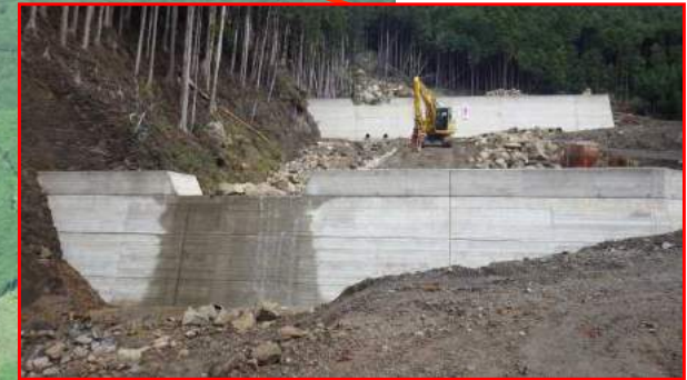
コンクリート土留工 施工状況
