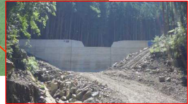
支流第1号コンクリート谷止工 完成状況
