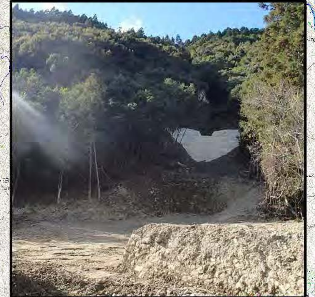
完成状況⑮(新宮市熊野川町九重和田)
