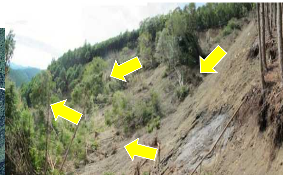
山腹崩壊地の状況
