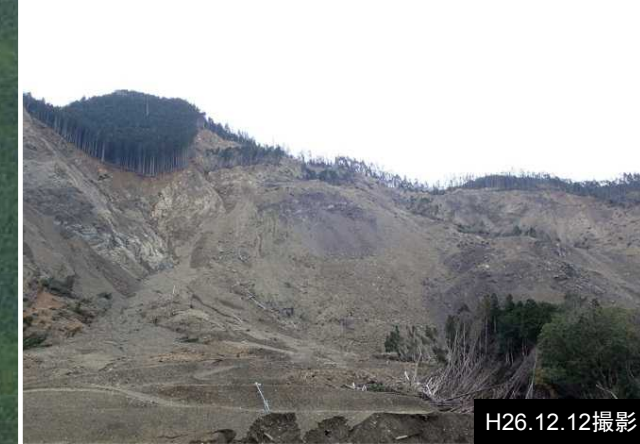
③崩壊斜面 現況
