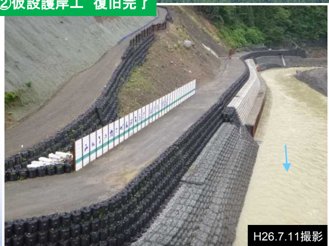
②仮設護岸工 復旧完了
