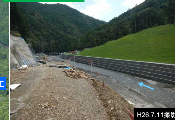
③流路護岸工 完成
