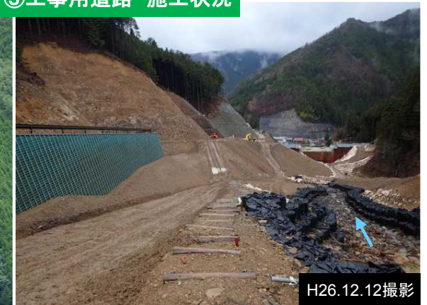
③工事用道路 施工状況
