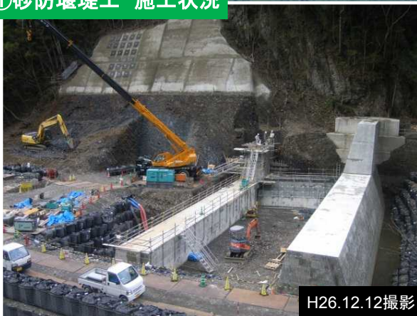
①砂防堰堤工 施工状況
