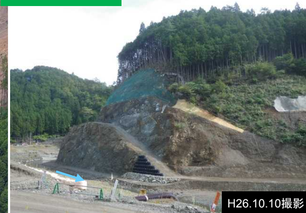
②河道拡幅 現況
