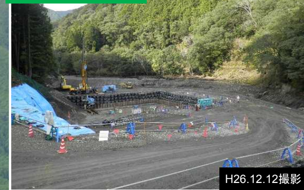
②床固工 施工状況
