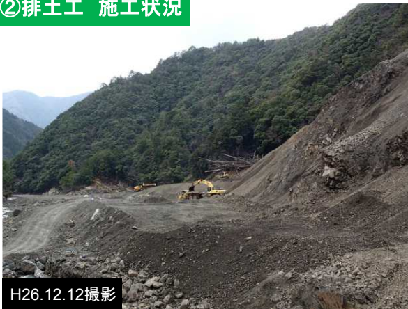
②排土工 施工状況
