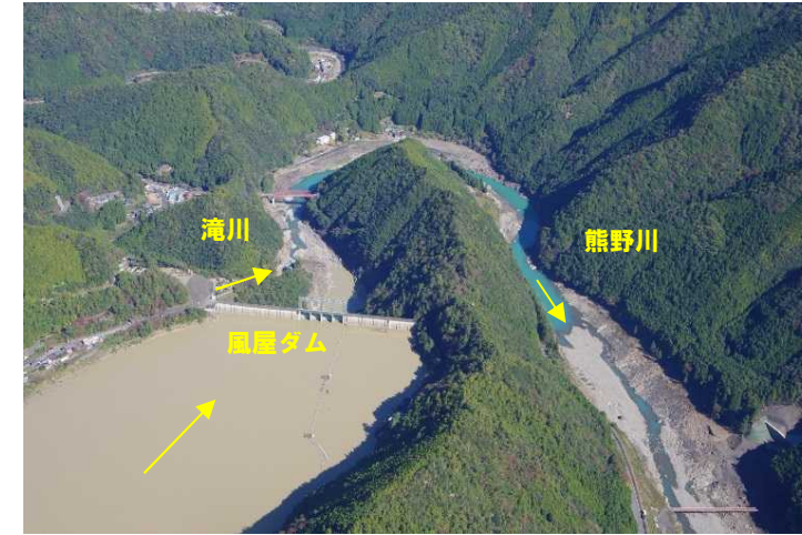
風屋ダム及びその下流
