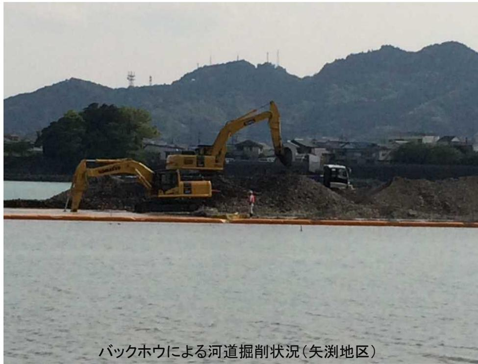
バックホウによる河道掘削状況（矢漕地区）
