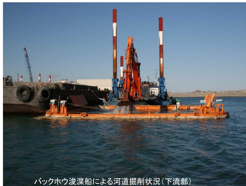
バックホウ浚渫船による河道掘削状況（下流部）
