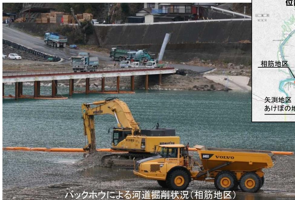
バックホウによる河道掘削状況（相筋地区）
