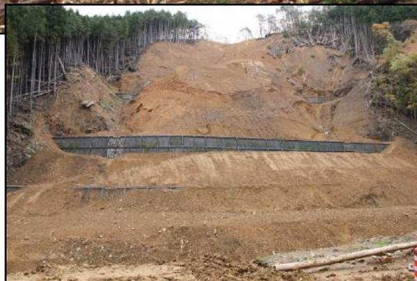
鋼製枠土留工 完成状況
