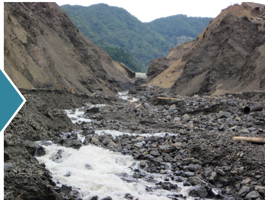
被災後（平成24年10月2日）
