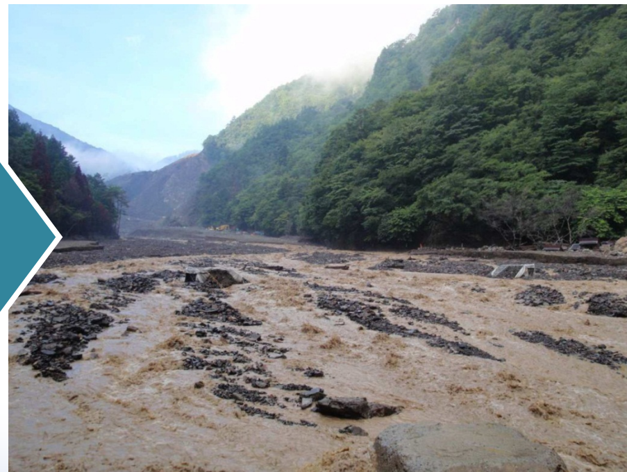
被災後（平成24年9月19日）
