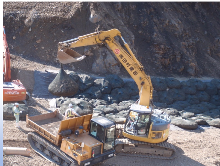
仮排水路末端部分の 保護工事作業
