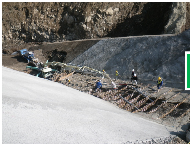
仮排水路シュート部の補強作業のようす
