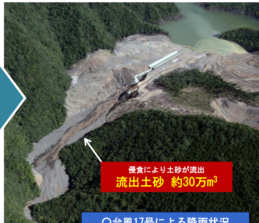
被災後（平成24年10月1日）
