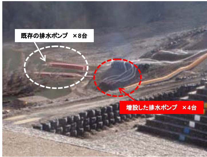
排水ポンプ増設による 湛水池の水位低下
