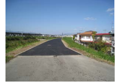
天端舗装(藻川1.4K付近)【H28】
