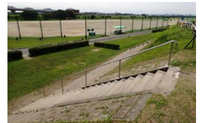
新設された手摺り(H28)
