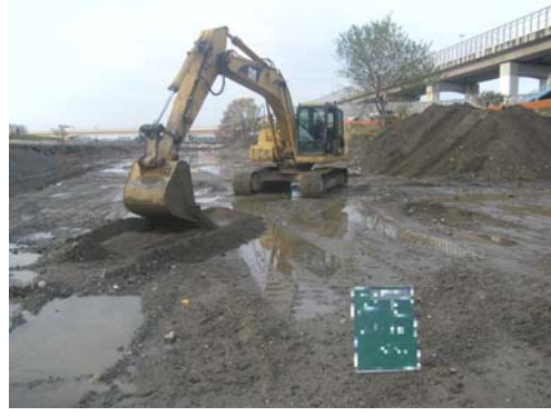
川西・池田地区河道掘削(H27)
