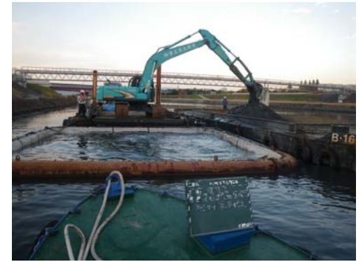
戸ノ内地区河道掘削(H28)
