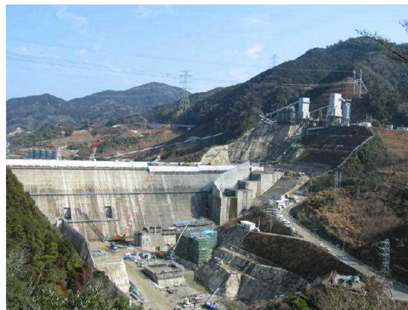
堤体工（他ダム事例）
