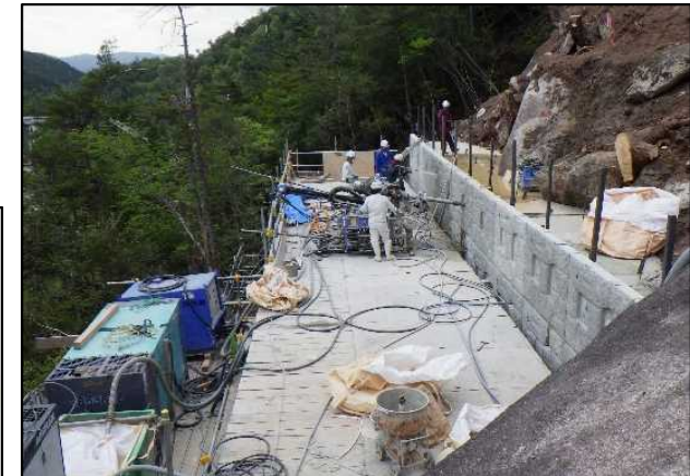
補強土壁の設置状況
