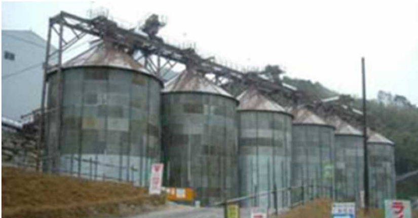
骨材設備写真（他ダム事例）
