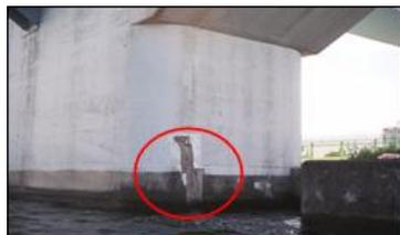
淀川大堰堰柱コンクリートの剥離
