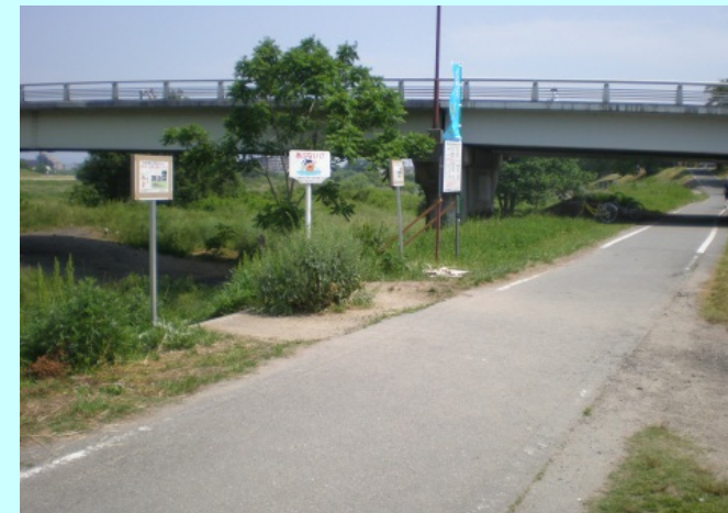
警告看板設置(桂川右岸15.8k付近)
