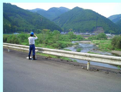
貯水池巡視状況
