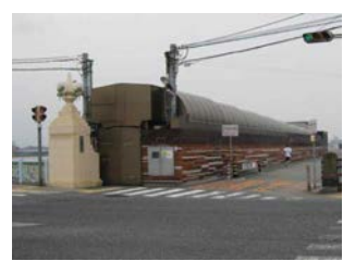
耐震対策予定 淀川陸閘（左岸）
