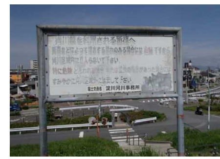
注意喚起看板(淀川) 補修前
