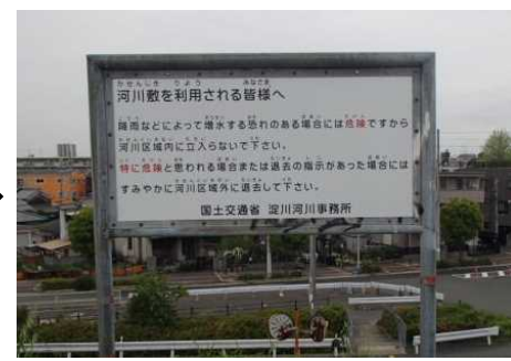
注意喚起看板(淀川) 補修後
