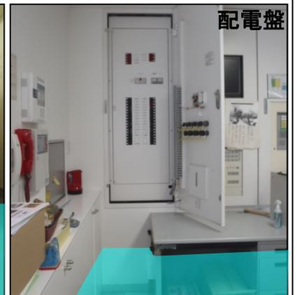
「草津市大路市民センター」は、草津川の浸水想定区域(浸水深0.5m~1.0m)に位置し、草津市建築物浸水対策に関する条例に基づき、洪水時避難場所としての機能を維持するため、受水槽および配電盤を浸水想定水位以上の高さに設置しています。
