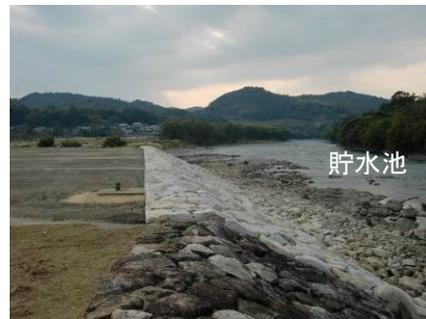
また、大石川合流地点は貯水池上流に位置し、貯水位の水位変動による影響を受けており、法面浸食が進行しているため、護岸整備を実施している。
