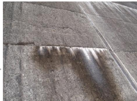
下流堤体面の漏水状況確認
