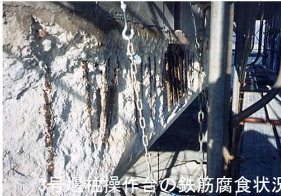
3号堰扉操作室の鉄筋腐食状況
