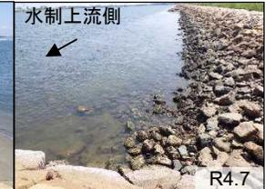
令和4年度調査時の土砂移動の上流端(下流側から3つ目の水制付近まで砂が堆積)
